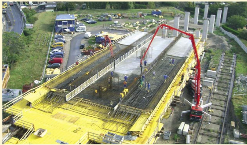
Herstellung Stationstragwerk der Station „Stadlau“
