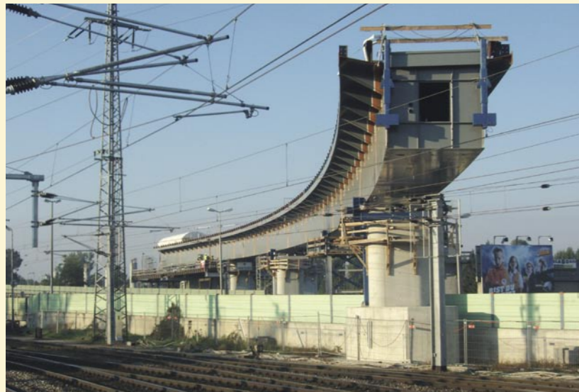
Stahlbrückenvorschub über A23 und ÖBB Bahnhof „Stadlau“
