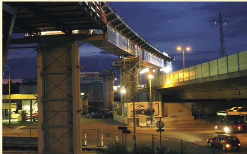
Stahlbrückenvorschub über Neuhaufenstraße und A23
