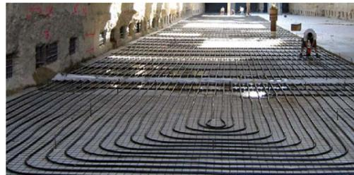
Erdwärmekollektoren unter der Bodenplatte
