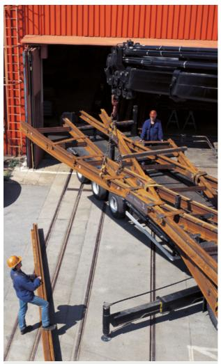
Eine komplette Weichenanlage wird für den Abtransport vorbereitet.
