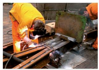
In der Montage müssen alle Teile verschweißt werden. Bei Vorwärmtemperaturen von 350 °C ist das, speziell im Sommer, kein leichter Job.
